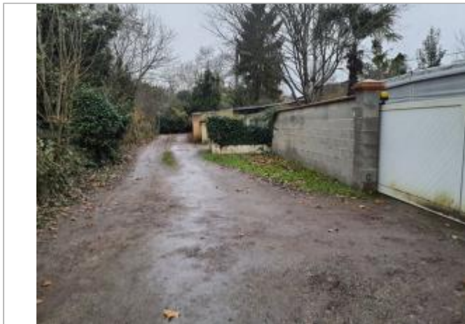
Marque sur structure Photo © AGERIN
