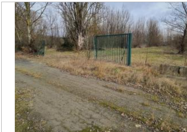
Marque sur structure Photo © AGERIN
