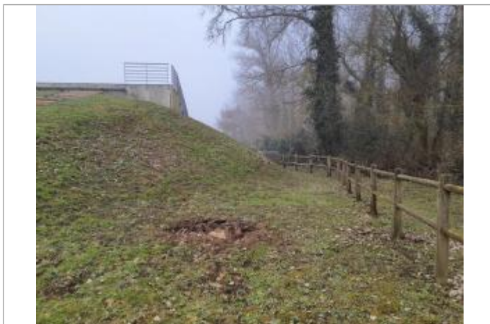
Marque sur structure Photo © AGERIN
