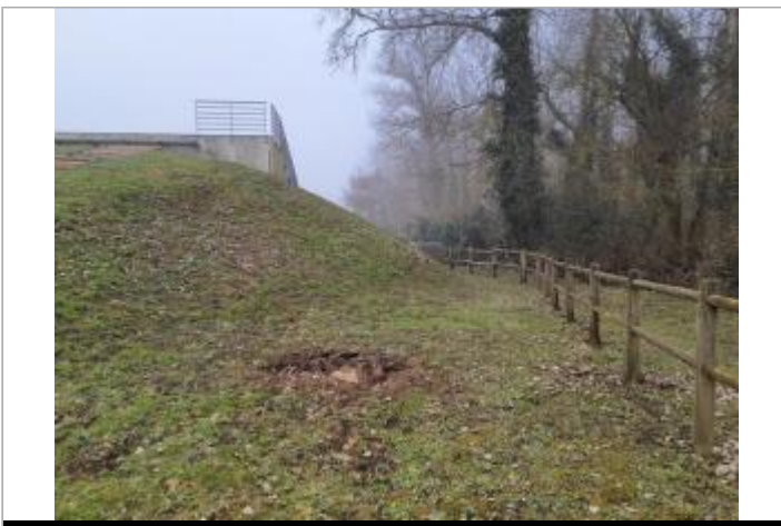
Marque sur structure Photo © AGERIN
