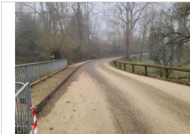
Marque sur structure Photo © AGERIN
