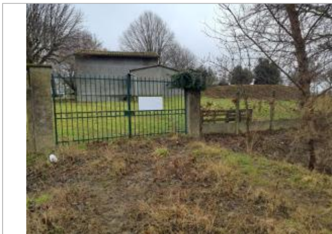
Marque sur structure Photo © AGERIN
