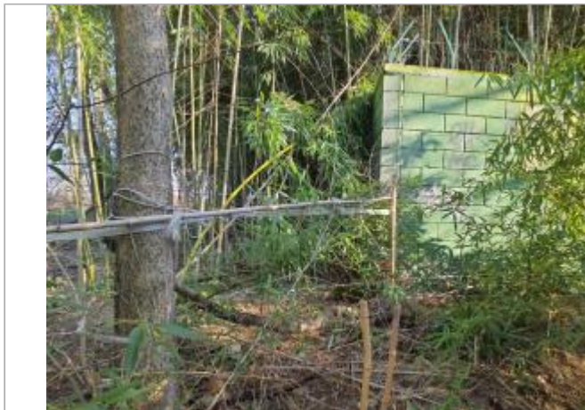
Marque sur structure Photo © AGERIN
