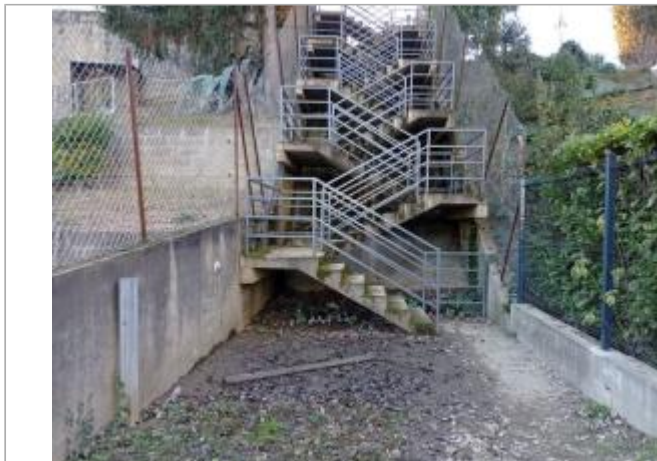
Marque sur structure Photo © AGERIN
