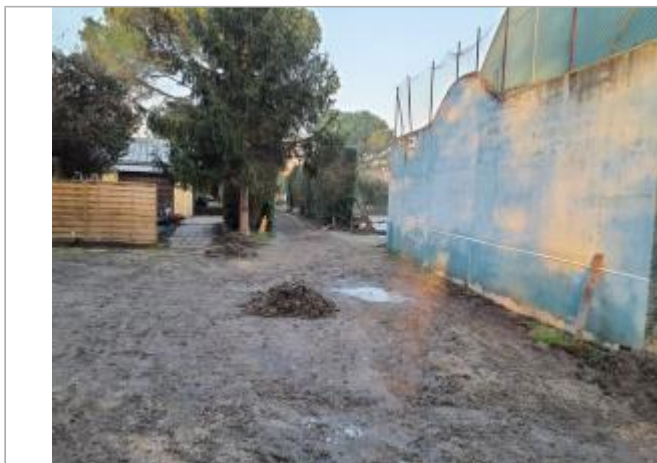
Marque sur structure Photo © AGERIN
