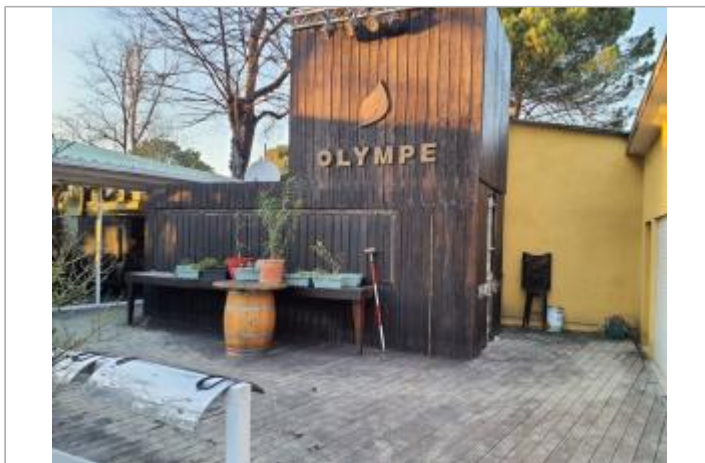
Marque sur structure Photo © AGERIN
