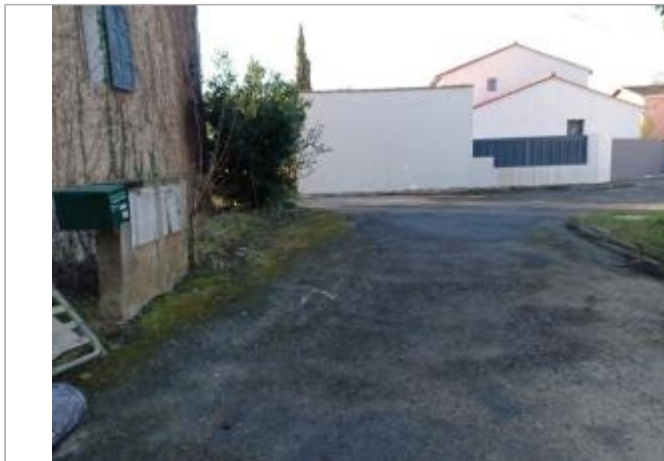
Marque sur structure Photo © AGERIN
