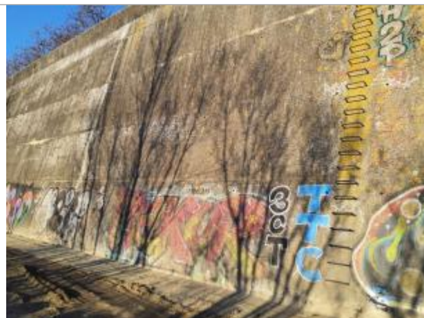
Marque sur structure Photo © AGERIN
