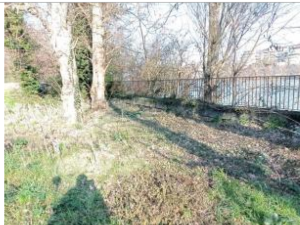
Marque sur structure Photo © AGERIN
