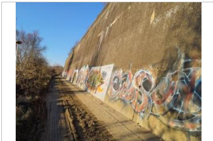
Marque sur structure Photo © AGERIN
