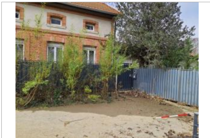
Marque sur structure Photo © AGERIN
