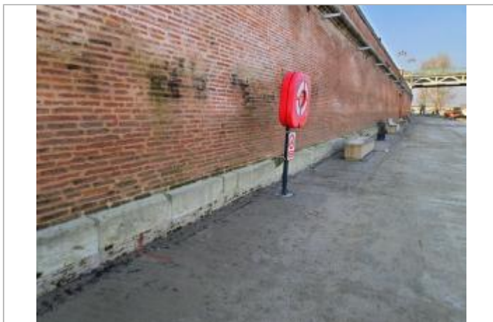
Marque sur structure Photo © AGERIN
