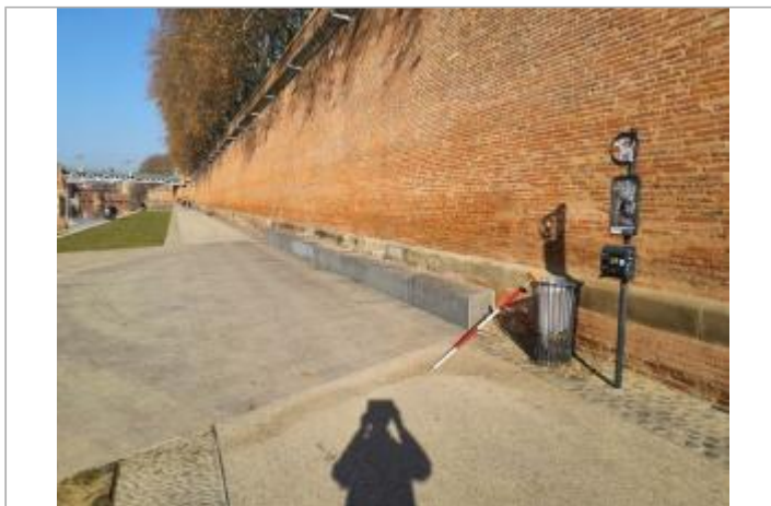
Marque sur poteau Photo © AGERIN
