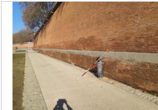
Marque sur structure Photo © AGERIN
