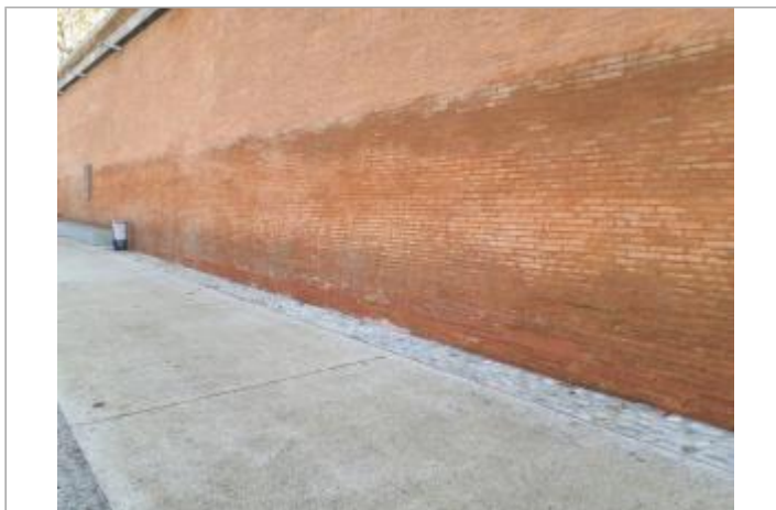
Marque sur structure Photo © AGERIN
