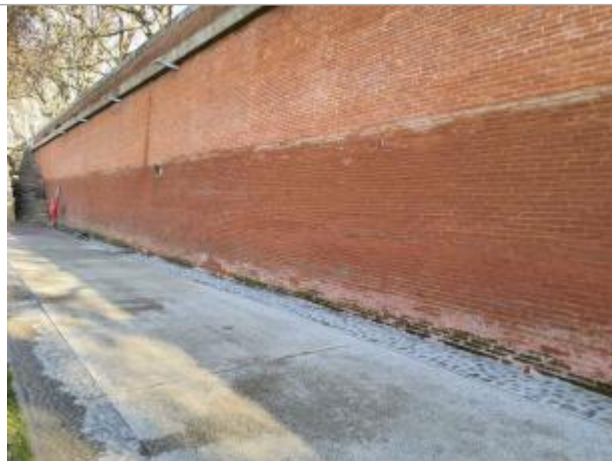
Marque sur structure Photo © AGERIN
