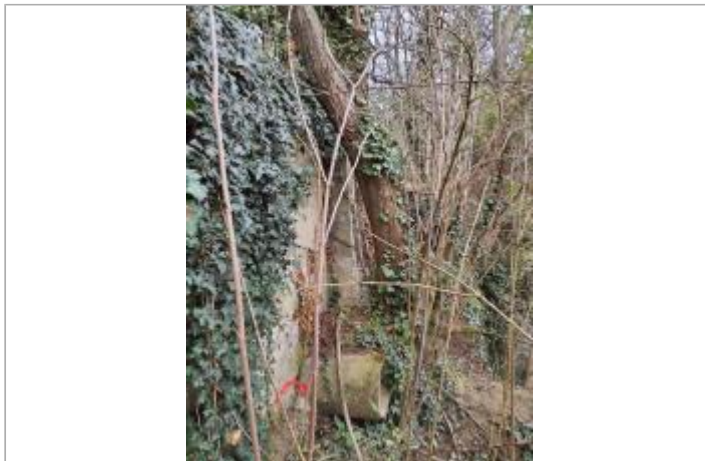
Marque sur structure Photo © AGERIN
