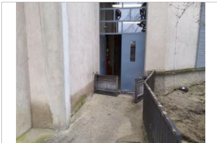
Marque sur structure Photo © AGERIN
