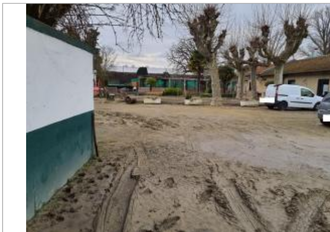
Marque sur structure Photo © AGERIN
