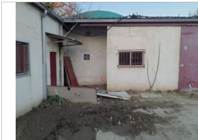
Marque sur structure Photo © AGERIN
