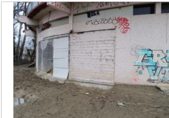
Marque sur structure Photo © AGERIN
