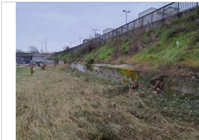
Marque sur structure Photo © AGERIN
