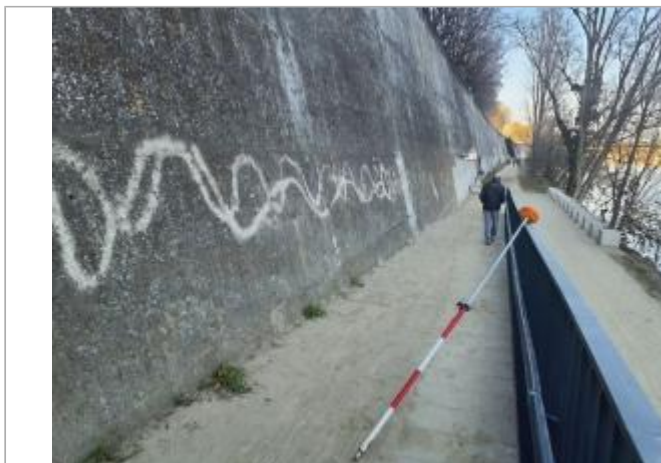
Marque sur structure Photo © AGERIN
