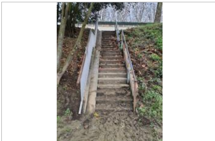
Marque sur structure Photo © AGERIN
