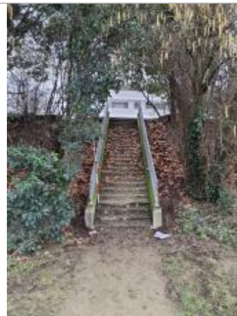
Marque sur structure Photo © AGERIN
