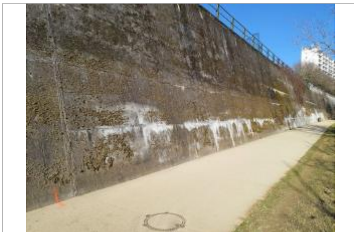
Marque sur structure Photo © AGERIN
