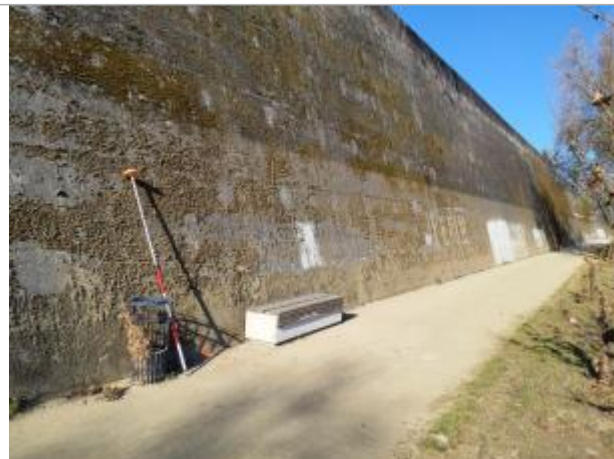
Marque sur structure Photo © AGERIN
