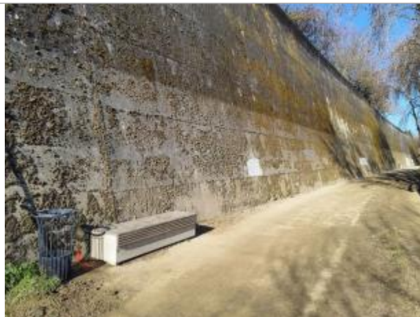
Marque sur structure Photo © AGERIN
