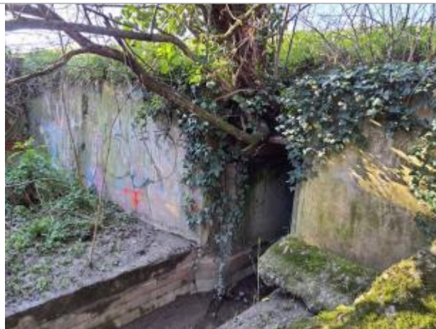
Marque sur structure Photo © AGERIN
