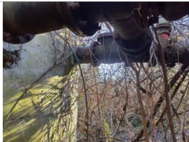
Marque sur structure Photo © AGERIN
