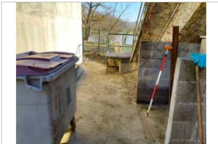
Station d'épuration sur Rue de Bac Photo © AGERIN
