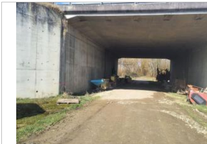
Marque sur structure Photo © AGERIN
