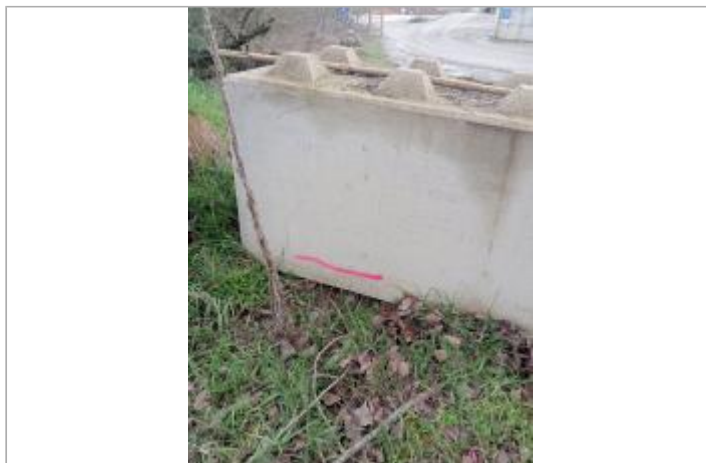
Marque sur structure Photo © AGERIN
