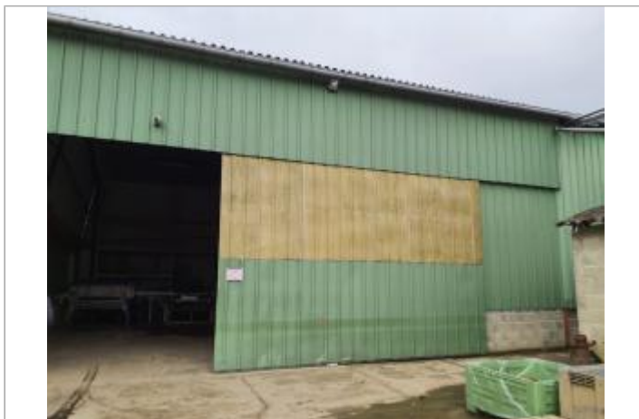
Marque sur structure Photo © AGERIN
