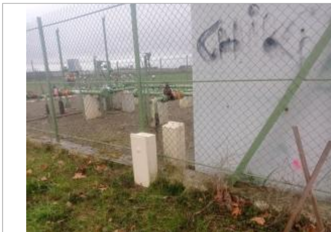
Marque sur structure Photo © AGERIN
