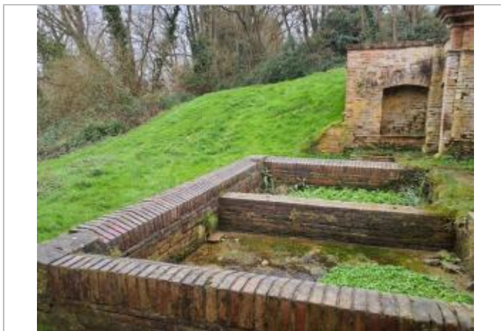
Marque sur structure Photo © AGERIN
