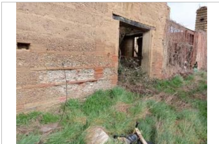
Marque sur structure Photo © AGERIN
