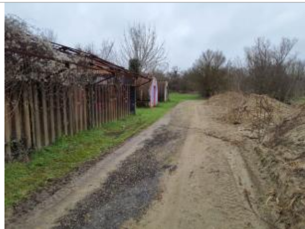
Marque sur structure Photo © AGERIN
