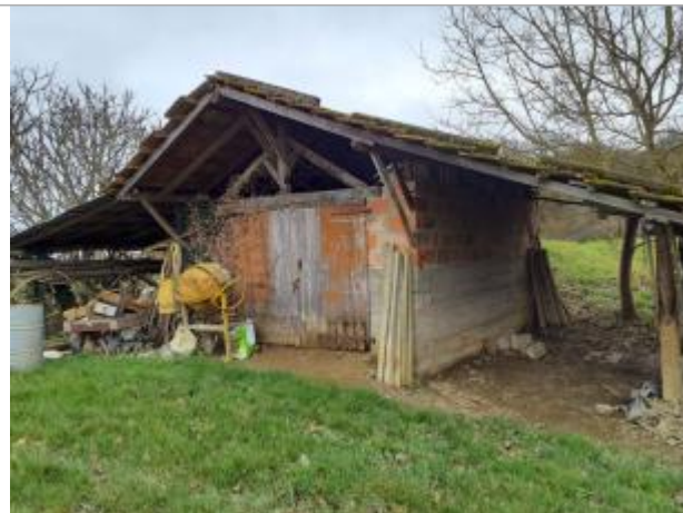
Marque sur structure Photo © AGERIN
