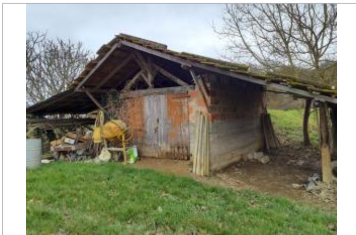
Marque sur structure Photo © AGERIN
