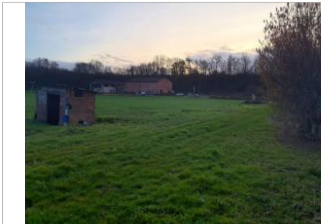
Marque sur structure Photo © AGERIN
