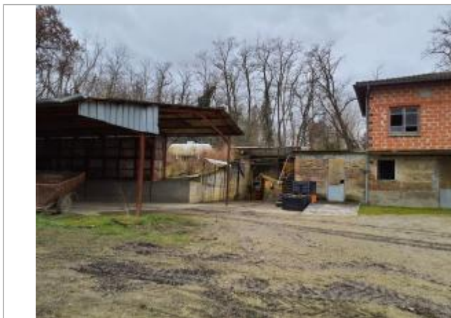
Marque sur structure Photo © AGERIN
