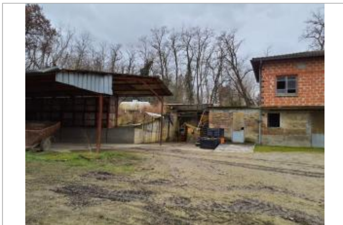
Marque sur structure Photo © AGERIN
