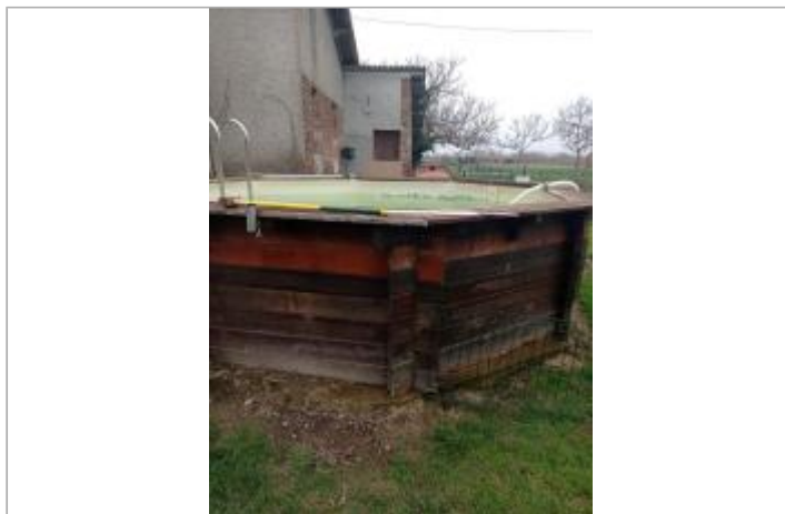
Marque sur structure Photo © AGERIN
