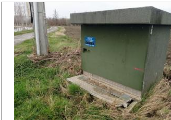
Marque sur structure Photo © AGERIN
