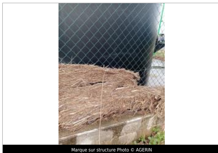
Marque sur structure Photo © AGERIN
