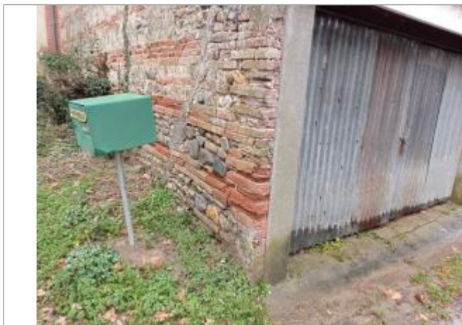
Marque sur structure Photo © AGERIN
