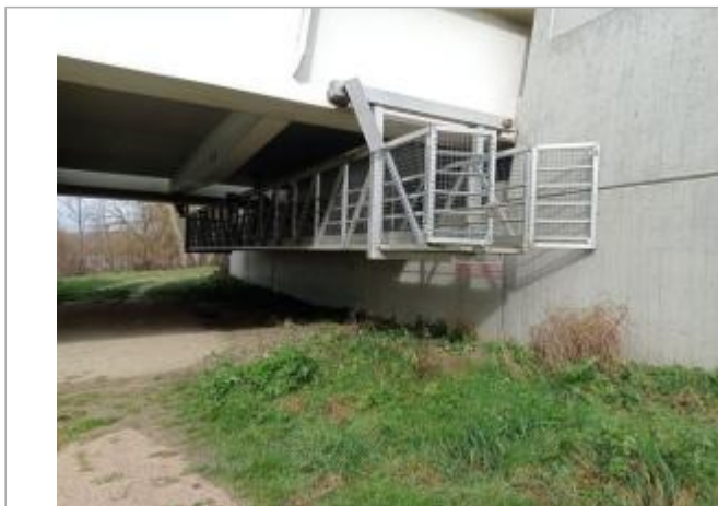
Marque sur structure Photo © AGERIN
