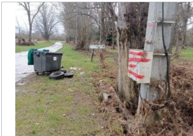
Marque sur structure Photo © AGERIN
